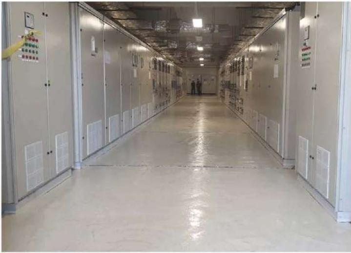
این روکش بر پایه رزین اپوکسی و سخت‌کننده ویژه به همراه افزودنی‌های خاص و استقرار نوارهای مسی و اتصال به چاه ارت، فرموله می‌شود و قابلیت هدایت الکتریکی و انتقال جریان الکتریسیته ساکن را دارد و به همین دلیل به روکش ضد جرقه نیز معروف است. این روکش کلیه خواص روکش اپوکسی اعم از خواص مکانیکی و شیمیایی، مقاومت سایشی و فشاری را دارد. از جمله مواد مصرف روکش آنتی استاتیک می‌توان به صنایع نظامی، انبارهای مواد قابل اشتعال، انواع های عمل، انواع کنترل، صنایع الکترونیک، انواع های اختلاط رنگ و ... اشاره کرد.
